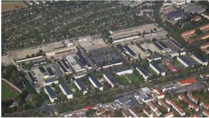
Luftbild Conn-Barracks Bestand Foto © Stadt Schweinfurt
